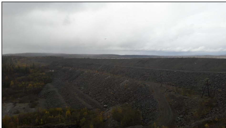
Внешний вид русловой плотины
