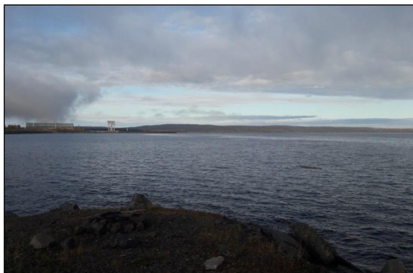
Р и с у н о к 3.3 – Курейское водохранилище ГЭС. Вид на здание гидроузла
