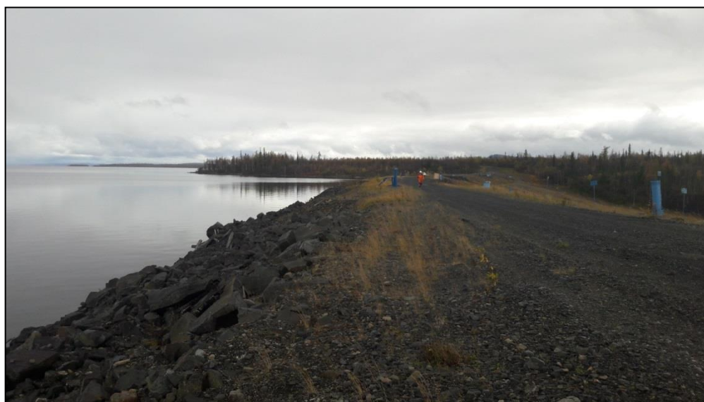
Правобережная плотина во II понижении
