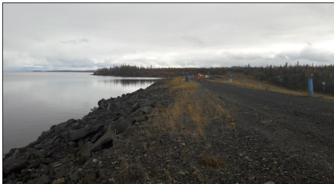
Р и с у н о к 3.6 – Внешний вид правобережной плотины во II понижении
